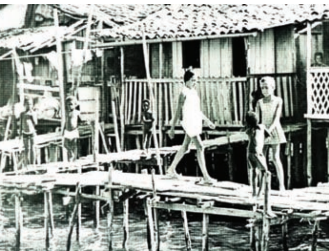
Palafitas em Alagados.
